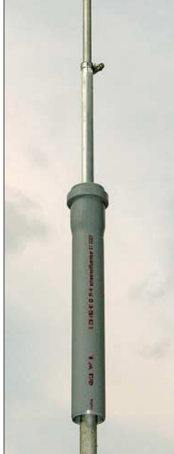
Bild 9: Das übergeschobene HT-Rohr schützt den Sperrkreis.
