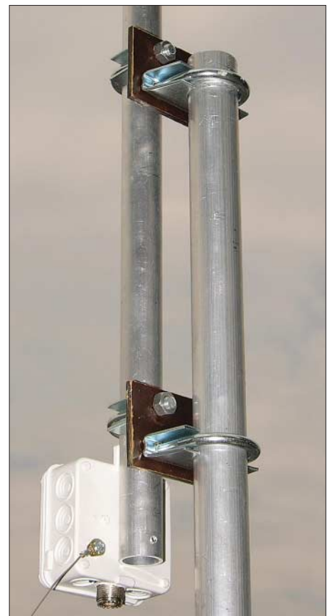
Bild 8: Isolierte Halterung für die Befestigung des Strahlers am Mast
