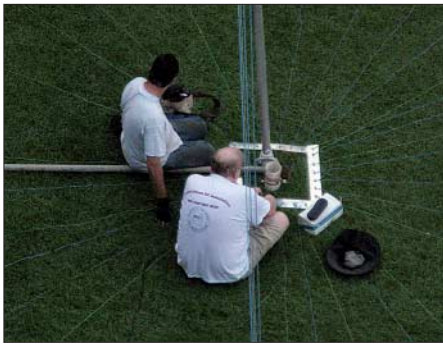
Mike, KC7V, und Ned, AA7A, beim Einrichten der Radials der Titanex-Vertikal Foto: G4IRN
